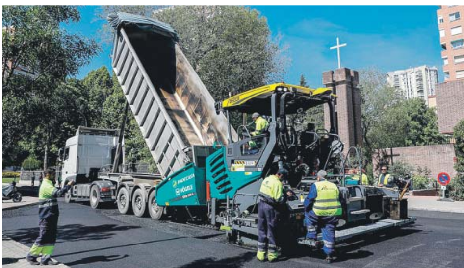
Operarios asfaltando una calle en Madrid. AYUNTAMIENTO DE MADRID
